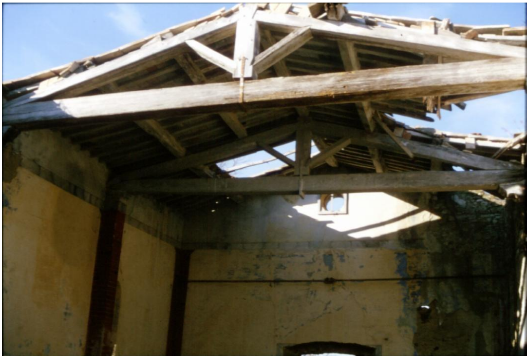
Il tetto della chiesa
