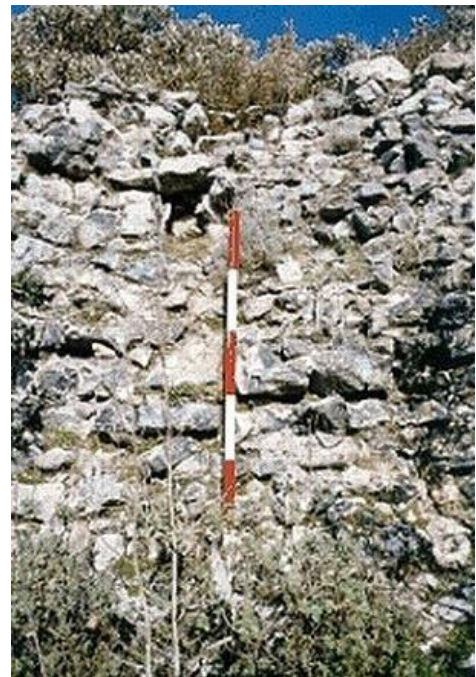
Tratto di muro perimetrale
